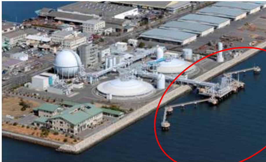
Hatsukaichi LNG terminal
