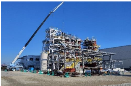
建設中の大野浦バイオマス発電所
