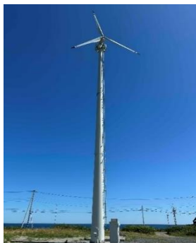
小形風車の外観 (宗谷郡猿払村)
