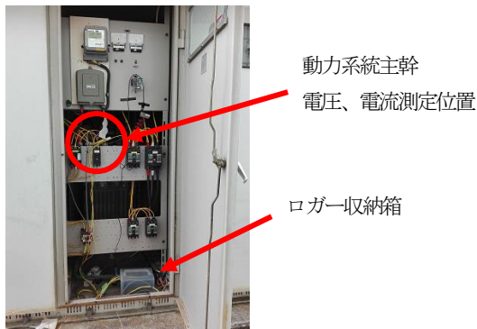
図 3.2 某スポーツ施設の電力計測
