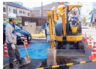
ガス導管の埋設工事
