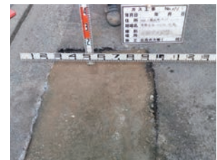
再生路盤材を使用した舗装工事
