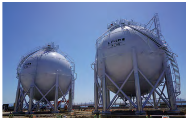
建設中のLPG貯槽
