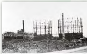
原爆で焼失した広島工場的气体ホルダー 撮影者：川本 俊雄、提供者：川本 祥雄
