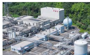
やまみ本社工場(写真奥)と備後工場(写真右手前)
