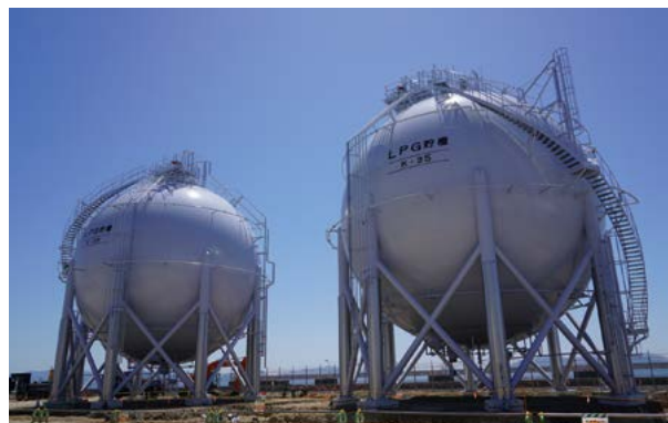
建設中のLPG貯槽
