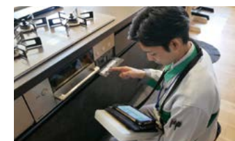
ガス設備安全点検
