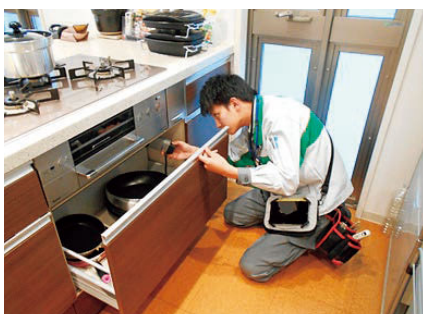
ガス設備安全点検
