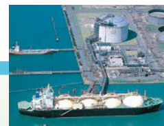
水島LNG基地 (水島エルエヌジー(株))
