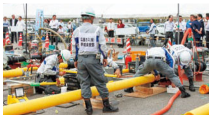
本支管技能コンクール
