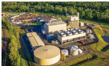
パースボロー発電所
