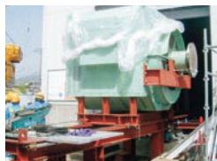
コージェネレーション改造工事
