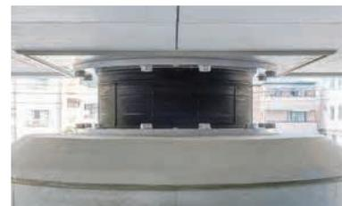
免震装置(柱頭免震構造)
