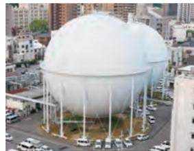
基礎部分は地中深くの支持地盤まで杭が打ち込まれています。その基礎上に支柱と球体を設置し、大規模地震にも耐えられるよう設計・施工しています。
