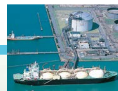
水島LNG基地 (水島エルエヌジー(株))
