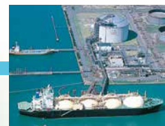
水島LNG基地 (水島エルエヌジー(株))
