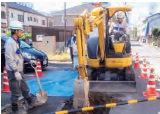
ガス導管の埋設工事
