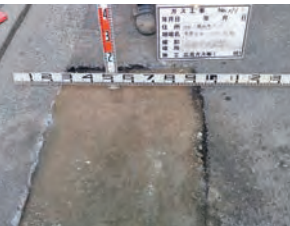
再生路盤材を使用した舗装工事
