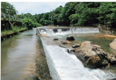
取水堰および導水路
