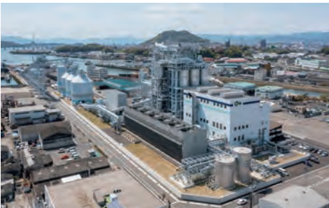
海田発電所(海田バイオマスパワー)
