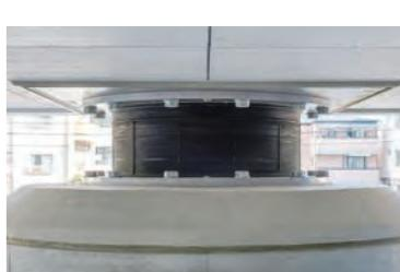
免震装置(柱頭免震構造)
