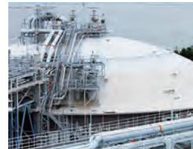
貯槽タンクは地下に構築した外壁の厚さが2m以上のコンクリートピット内に据え付けられ、内部のLNG液面は地表よりも低く、万一の場合でも地上に漏れ出することはあります。
