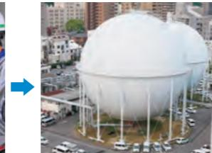
基礎部分は地中深くの支持地盤まで杭が打ち込まれています。その基礎上に支柱と球体を設置し、大規模地震にも耐えられるよう設計・施工しています。
