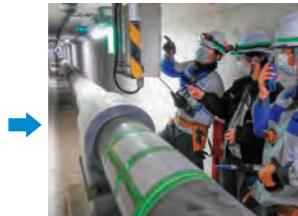
高い圧力のガスを輸送する導管には、耐震性に優れ、大きな地盤変動にも耐える「溶接接合鋼管」を使用しています。
