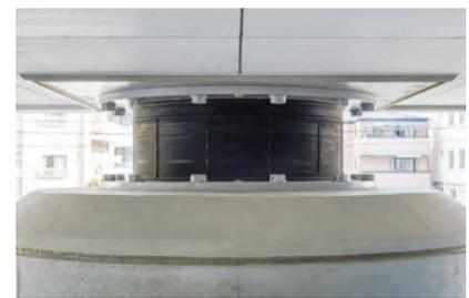
免震装置(柱頭免震構造)
