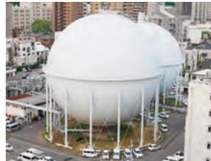
基礎部分は地中深くの支持地盤まで杭が打ち込まれています。その基础上に支柱と球体を設置し、大規模地震にも耐えられるよう設計・施工しています。
