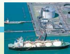
水島LNG基地 (水島エルエヌジー(株))
