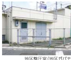
地区整圧室(地区ガバナ)
