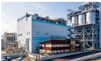
管理事務所・タービン棟・ボイラ
