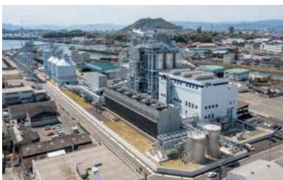
海田発電所(海田バイオマスパワー)
