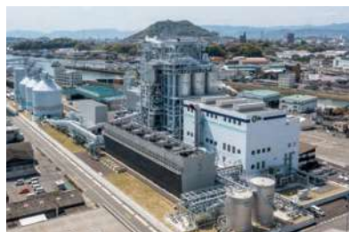
海田発電所(海田バイオマスパワー)(海田町明神町)
