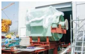
コージェネレーション改造工事
