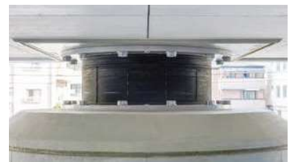
免震装置(柱頭免震構造)
