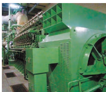
ガスコージェネレーションシステム(廿日市工場)
