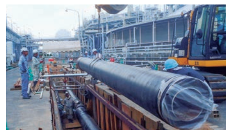
温水二重管設置工事
