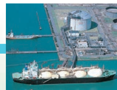
水島LNG基地 (水島エルエヌジー(株))
