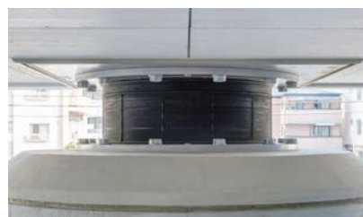
免震装置(柱頭免震構造)
