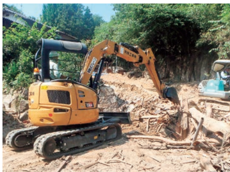
土砂の撤去作業
