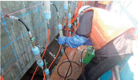
総合的コンクリート補修システム『リハビリ工法』施工の様子 (広島ガステクノ・サービス(株))
