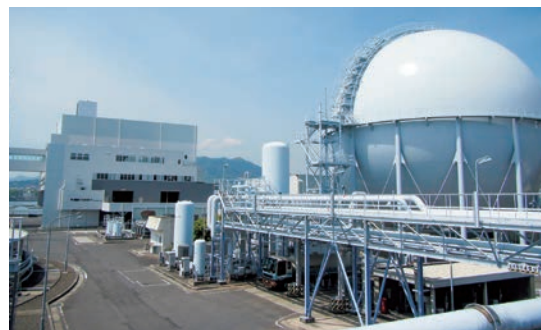
▲ 廿日市工場側から、「はつかいちエネルギーグリーンセンター」を臨む
