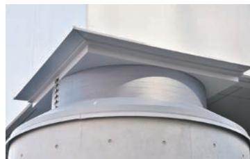
免震装置を柱上部に設置し、執務室の空間の横揺れを大幅に軽減。1階の柱(9本)は丸柱とし、津波・浮遊物の衝撃を受け流すことができる構造としました。
