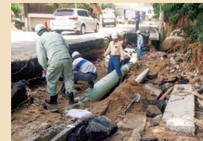
ガス管が露出した部分を点検補修
