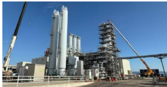
建設中のLAES商用実証プラント(廿日市工場内)
