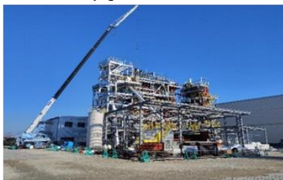
建設中の大野浦バイオマス発電所
