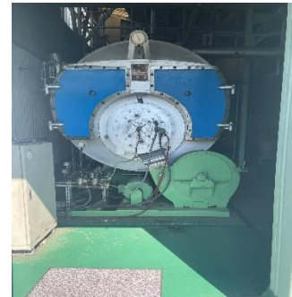
(燃転前) 炉筒煙管ボイラ
