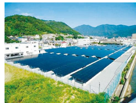
阿賀太陽光発電所(呉市)
