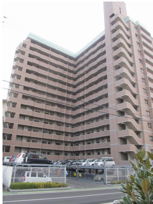
【集合住宅 (91戸、東広島市) の燃料転換】
