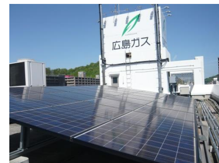
太陽光発電(尾道支店屋上)
