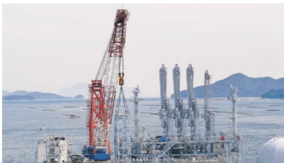
廿日市工場の棧橋機能拡大工事
