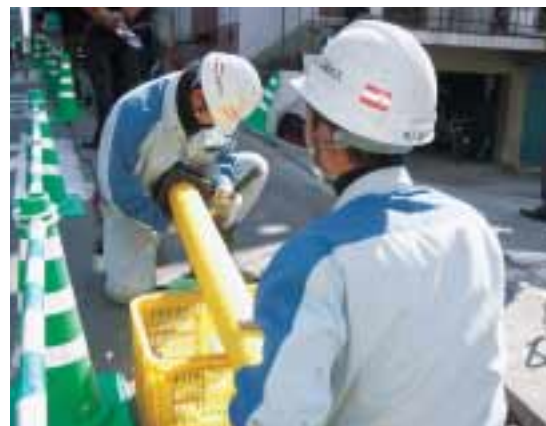
経年ガス導管入れ替え作業
