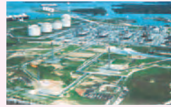
インドネシア ボンタン基地
