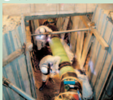
導管埋設工事
