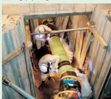
導管埋設工事
