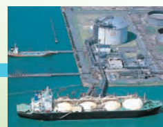
水島LNG基地 (水島エルエヌジー(株))
