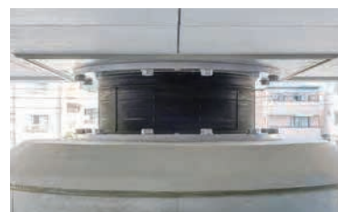
免震装置(柱頭免震構造)
