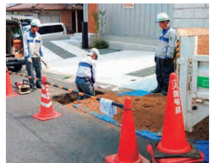
ガス管工事
