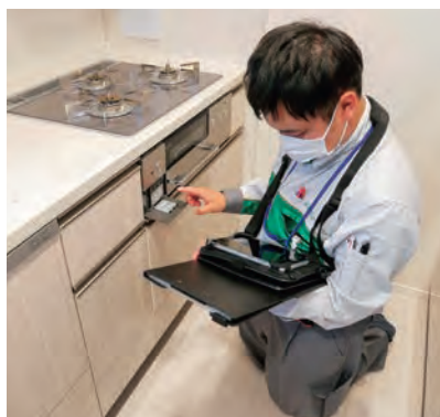
ガス設備安全点検
