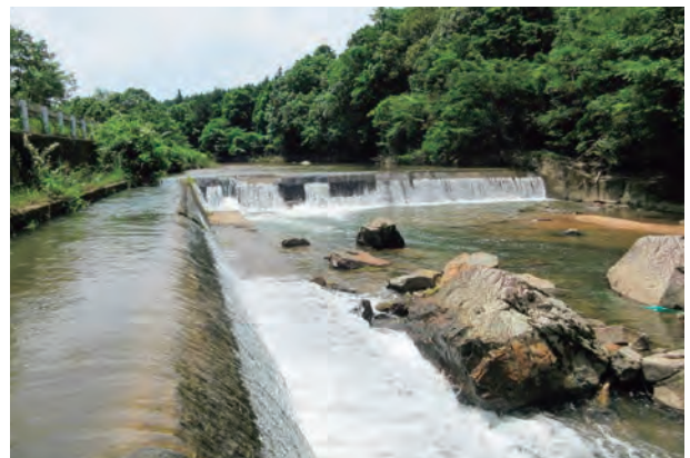
取水堰および導水路
