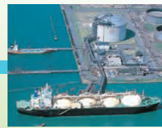
水島LNG基地 (水島エルエヌジー(株))
