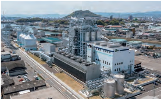
海田発電所(海田バイオマスパワー)
