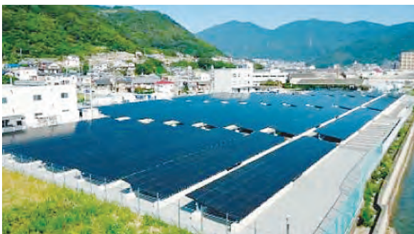
阿賀太陽光発電所
