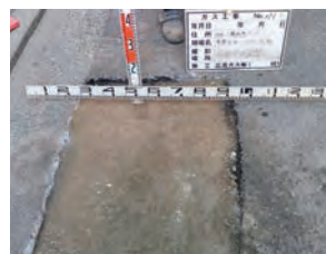
再生路盤材を使用した舗装工事
