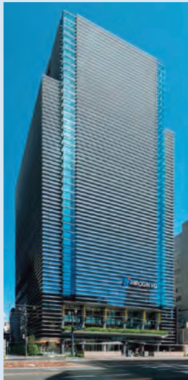
ひろぎんホールディングス 本社ビル(CN都市ガス供給先)
