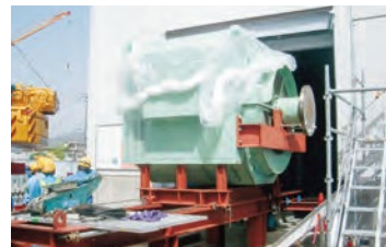
コージェネレーション改造工事
