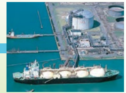
水島LNG基地 (水島エルエヌジー(株))
