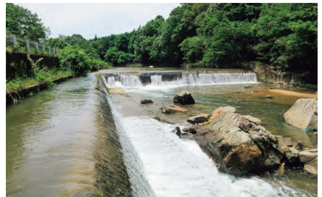
取水堰および導水路
