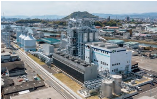
海田発電所(海田バイオマスパワー)
