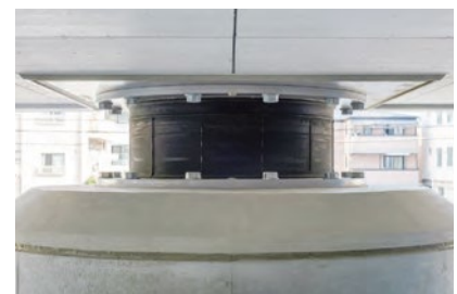
免震装置(柱頭免震構造)
