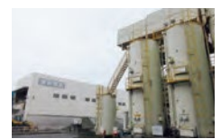
産業廃棄物処理施設実地確認
