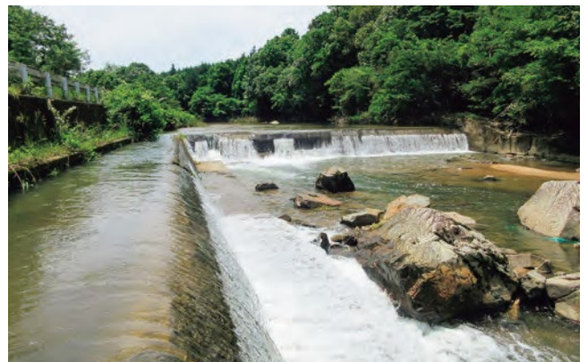
取水堰および導水路
