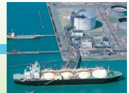
水島LNG基地 (水島エルエヌジー(株))
