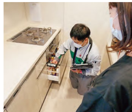
ガス設備安全点検
