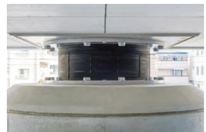
免震装置(柱頭免震構造)
