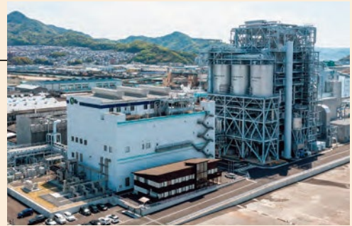
海田発電所(バイオマス発電)
