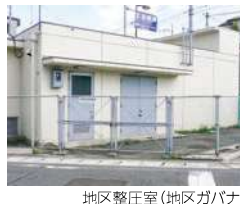
地区整圧室(地区ガバナ)
