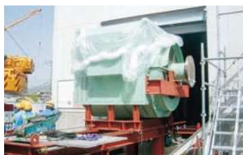
コージェネレーション改造工事
