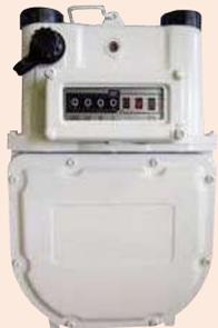
ガスを使用中に震度5程度以上の地震を感知すると、マイコンメーターの安全装置が作動し、お客さま宅のガス供給を自動的に遮断します。広島ガスでは、例外を除き、マイコンメーターを100%設置しています。
