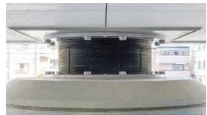
免震装置(柱頭免震構造)
