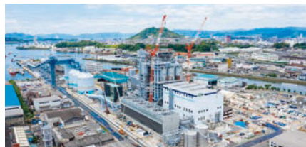
建設中の海田発電所
