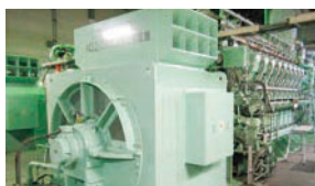
ガスコージェネレーションシステム(廿日市工場)
