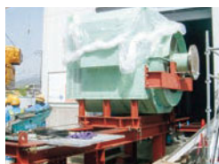
コージェネレーション改造工事
