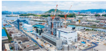
建設中の海田発電所
