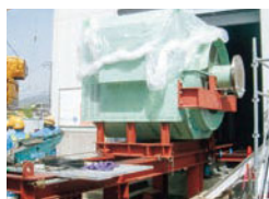
コージェネレーション改造工事
