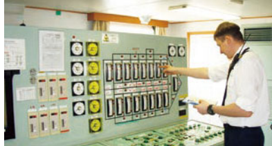
パラスト水確認作業
