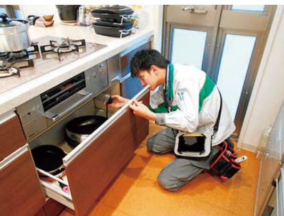
ガス設備安全点検
