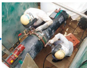
《 高圧・中圧導管 》
