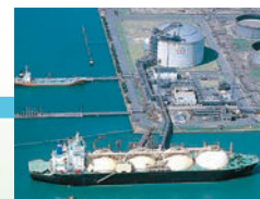
水島LNG基地 (水島エルエヌジー(株))
