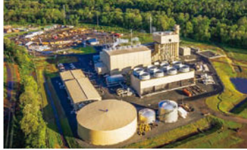
パースボロー発電所
