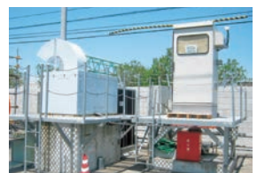
ガス差圧発電装置
