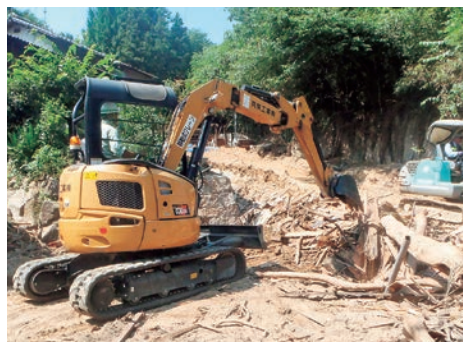
土砂の撤去作業
