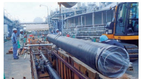
温水二重管設置工事
