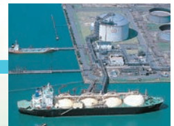
水島LNG基地 (水島エルエヌジー(株))
