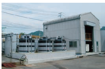
水処理装置（海田基地）
