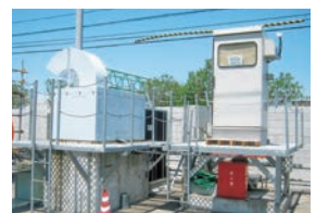
ガス差圧発電装置
