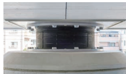
免震装置(柱頭免震構造)
