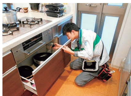
ガス設備安全点検
