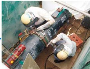
高い圧力のガスを輸送する導管には、耐震性に優れ、大きな地盤変動にも耐える「溶接接合鋼管」を使用しています。
