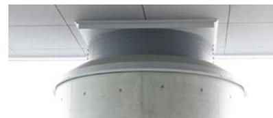
免震装置を柱上部に設置し、執務室の空間の横揺れを大幅に軽減。1階柱(9本)を丸柱とし、津波・浮遊物の衝撃を受け流すことのできる構造になっています。
