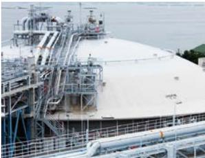
貯槽タンクは地下に構築した外壁の厚さが2m以上のコンクリートピット内に据え付けられ、内部のLNG液面は地表よりも低く、万一の場合でも地上に漏れ出すことはありません。
