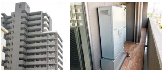
エネファーム集合住宅(広島市中区吉島西)
