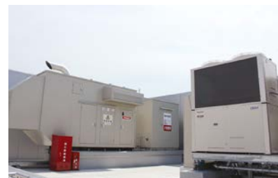
非常用発電機+電源自立型GHPエアコン
