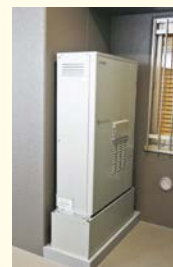
マンション向けエネファーム (広島市中区吉島)
